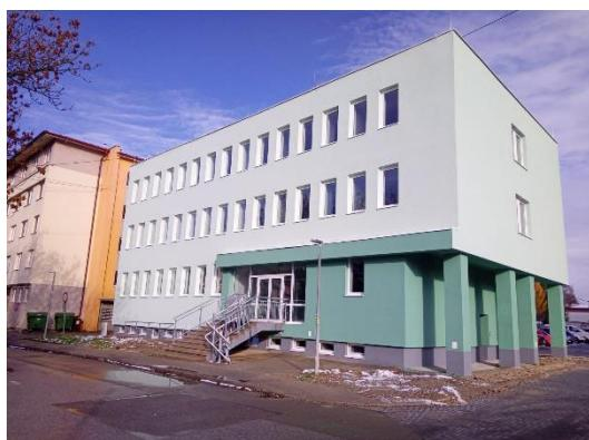
„ Prestavba objektu AB bývalých TSM na ul. Klčové v Novom Meste nad Váhom“ - Prestavba pôvodnej budovy, zateplenie strešného plášťa, výmena výplní otvorov - plastové okná a hliníkové dvere, zateplenie obvodového plášťa, výmena vykurovacích telies, kompletná rekonštrukcia elektroinštalácie, vodovodu a kanalizácie - 04/2021 - 11/2021
