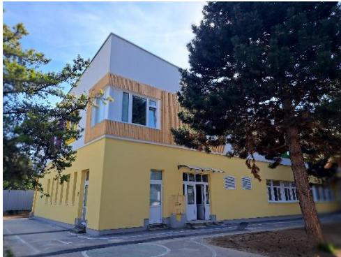
„Rozšírenie kapacity MŠ, Poľovnícka ul. 2039/12, Nové Mesto nad Váhom“ - Prestavba pôvodnej budovy, zateplenie strešného plášťa, výmena výplní otvorov - plastové okná a hliníkové dvere, zateplenie obvodového plášťa, výmena vykurovacích telies, kompletná rekonštrukcia elektroinštalácie, vodovodu a kanalizácie - 04/2023 - 09/2023
